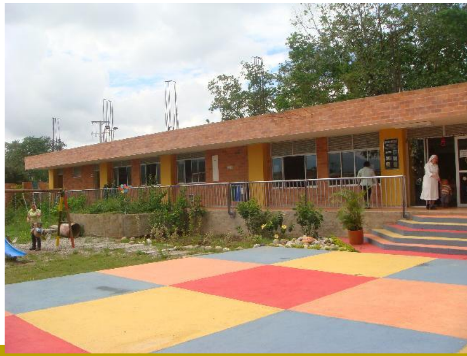
Fig. 1 Instalaciones del CAIF
